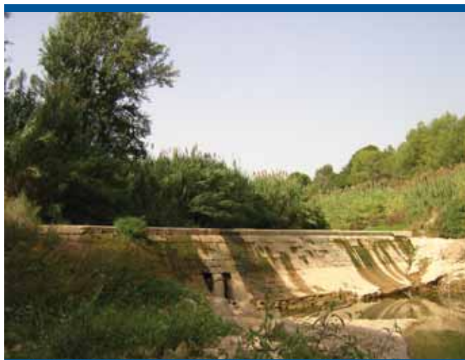
Azud de la Acequia Mayor de Sagunto (Sot de Ferrer)
